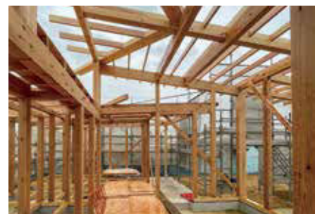
工事現場 材木が丁寧に組み上げられた上棟式の様子
